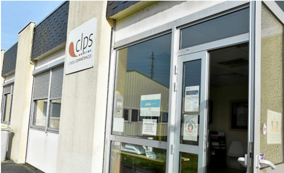
L'entrée du site du CLPS sur la zone Atlante à Quévert. (Le Télégramme/Valérie Le Moigne)
